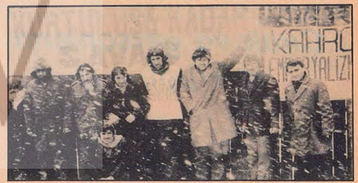
Kültür Sarayı Onarım inşaatındaki grevci işçiler.
